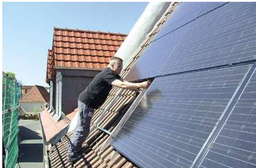
Montage einer Photovoltaik-Anlage durch versierte Mitarbeiter der Firma Seitner Haustechnik. Bild unten: „Wir wollen mit unserem Infotag Kunden ein möglichst breites Spektrum an zukunftsweisenden Technologien vorstellen und dabei auch unsere Leistungsfähigkeit nachhaltig unter Beweis stellen“, betonen die beiden Geschäftsführer Hannelore Seitner und Wilfried Dexheimer und freuen sich am 14. Mai über viele Interessierte. Fotos: privat/ns
